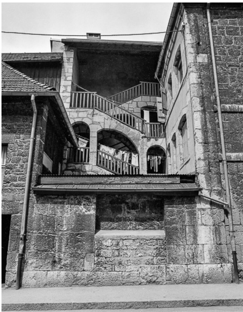
Escalier sur cour.
