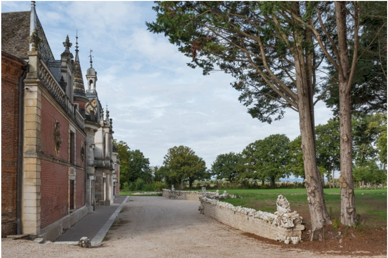
Chemin et muret en avant de l'élévation antérieure.
