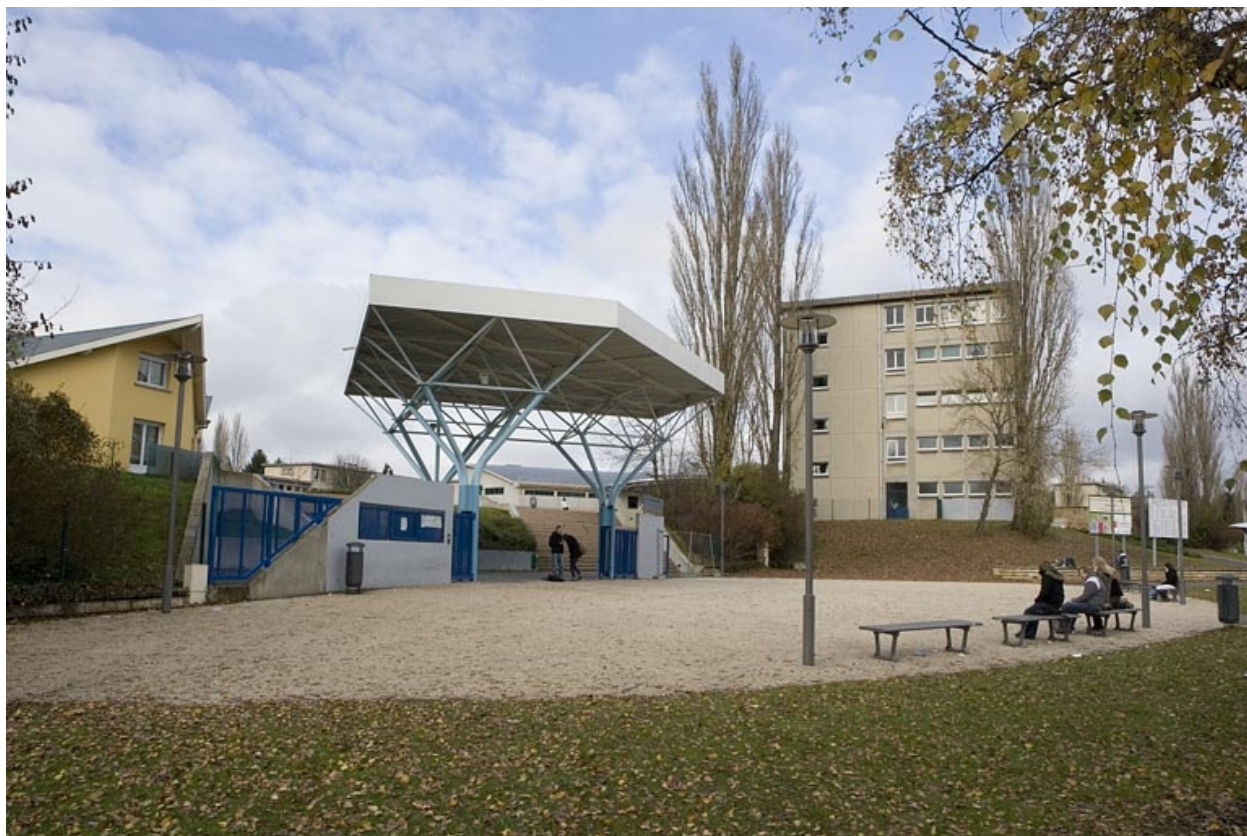
Vue de la nouvelle entrée.
