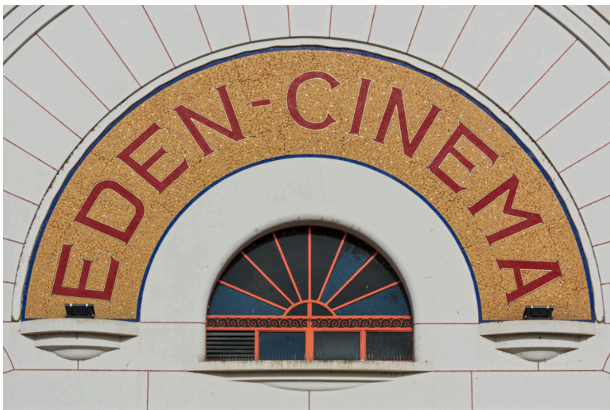
Façade antérieure, partie haute : baie et enseigne.
