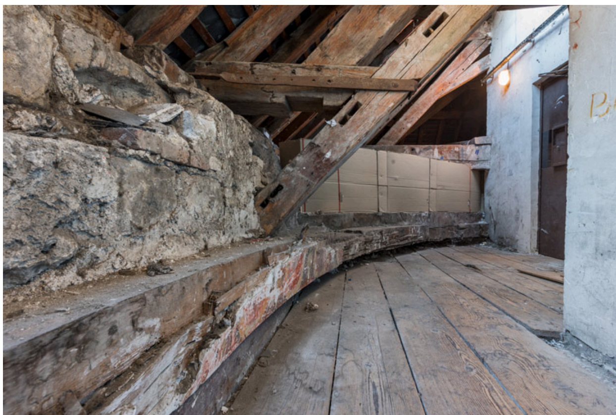
Comble de l'ancien théâtre : charpente et vestige de la coupole.
