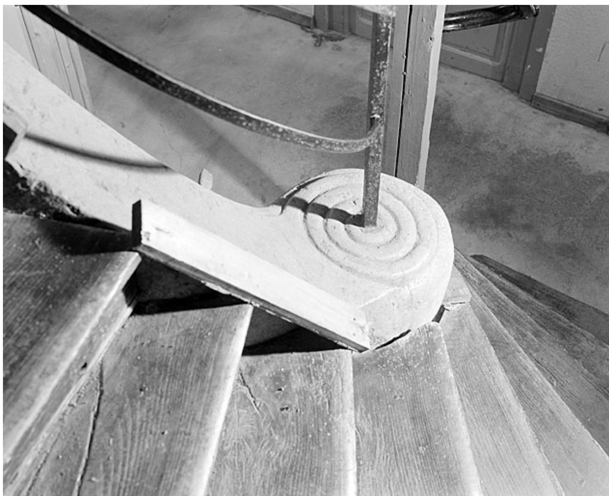
Escalier tournant : départ de la rampe d'appui.
