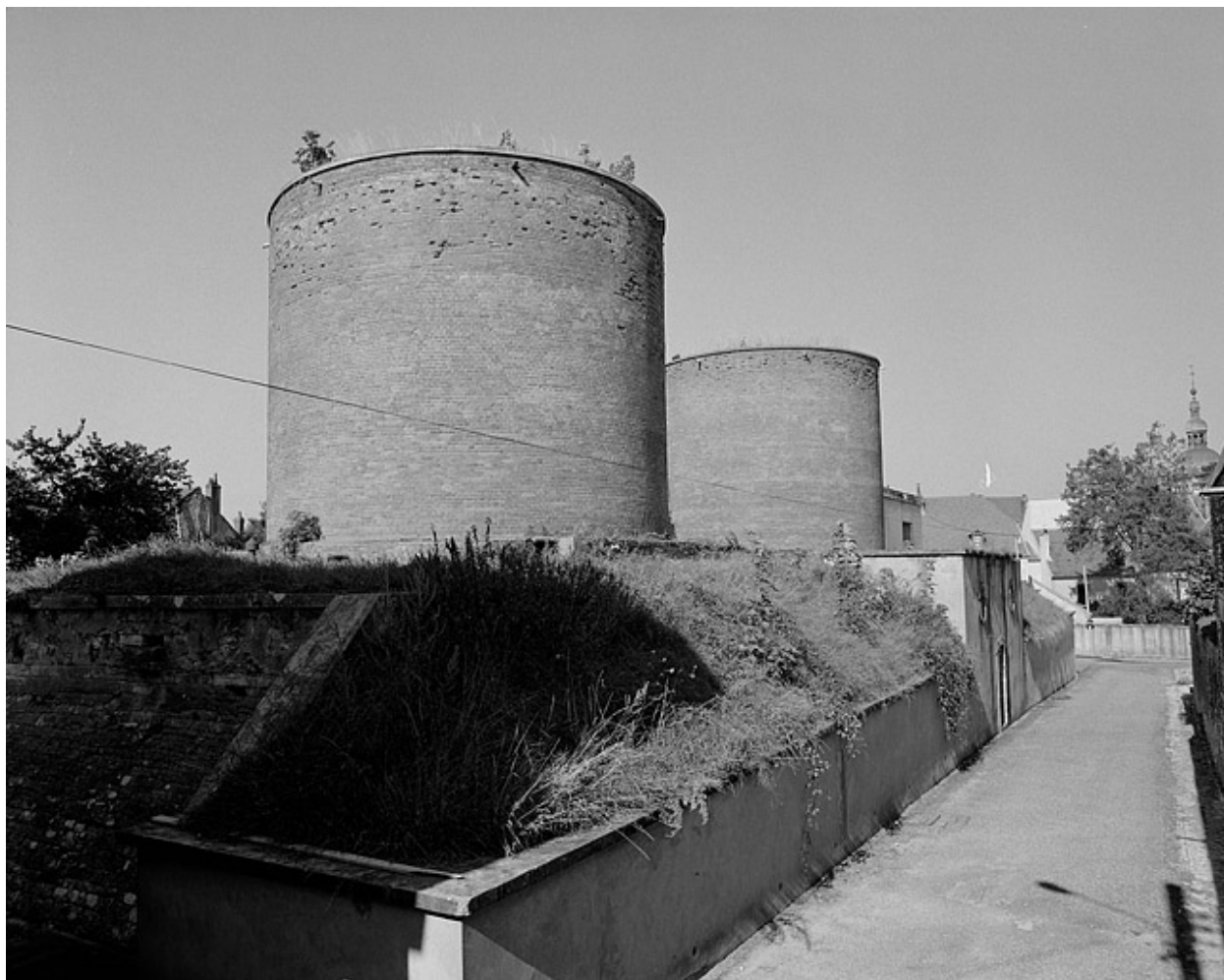
Vue des réservoirs depuis le revers.
