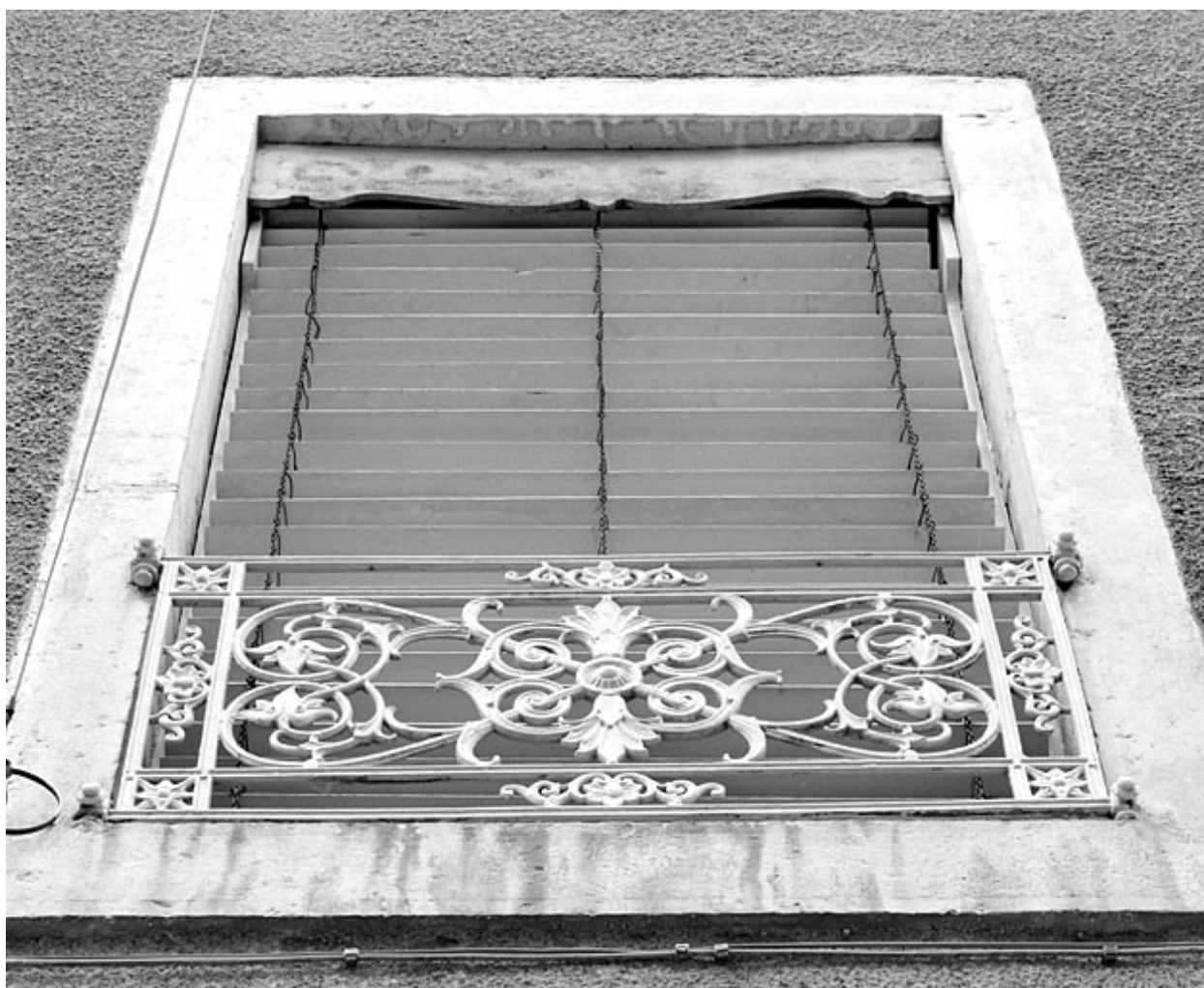
Fenêtre du premier étage et son garde-corps.
