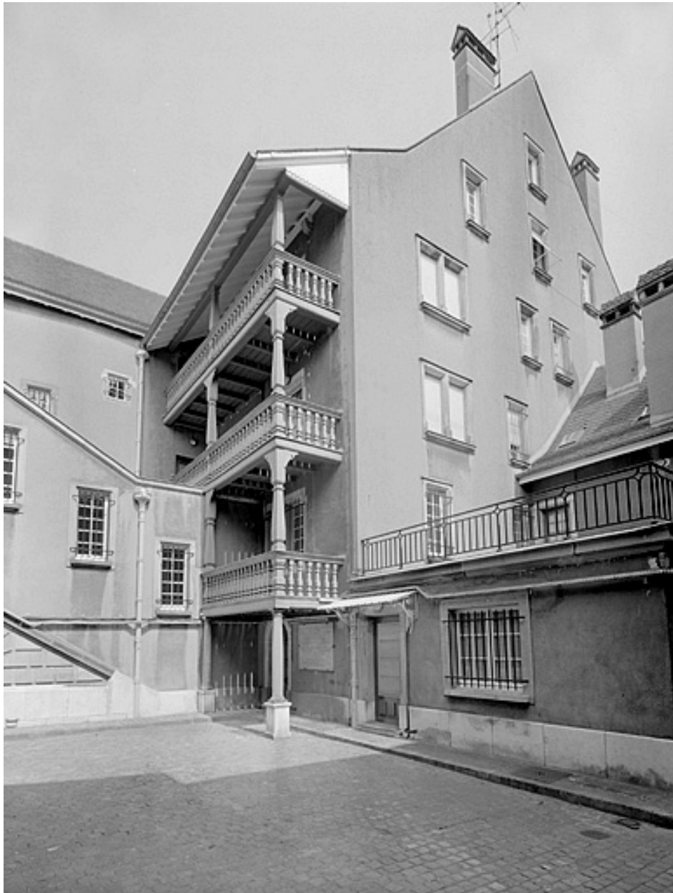
Façade sur cour.
