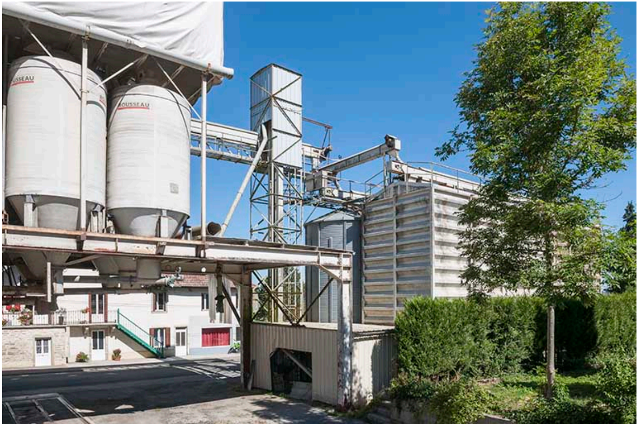
Silos et installations de chargement/déchargement.
