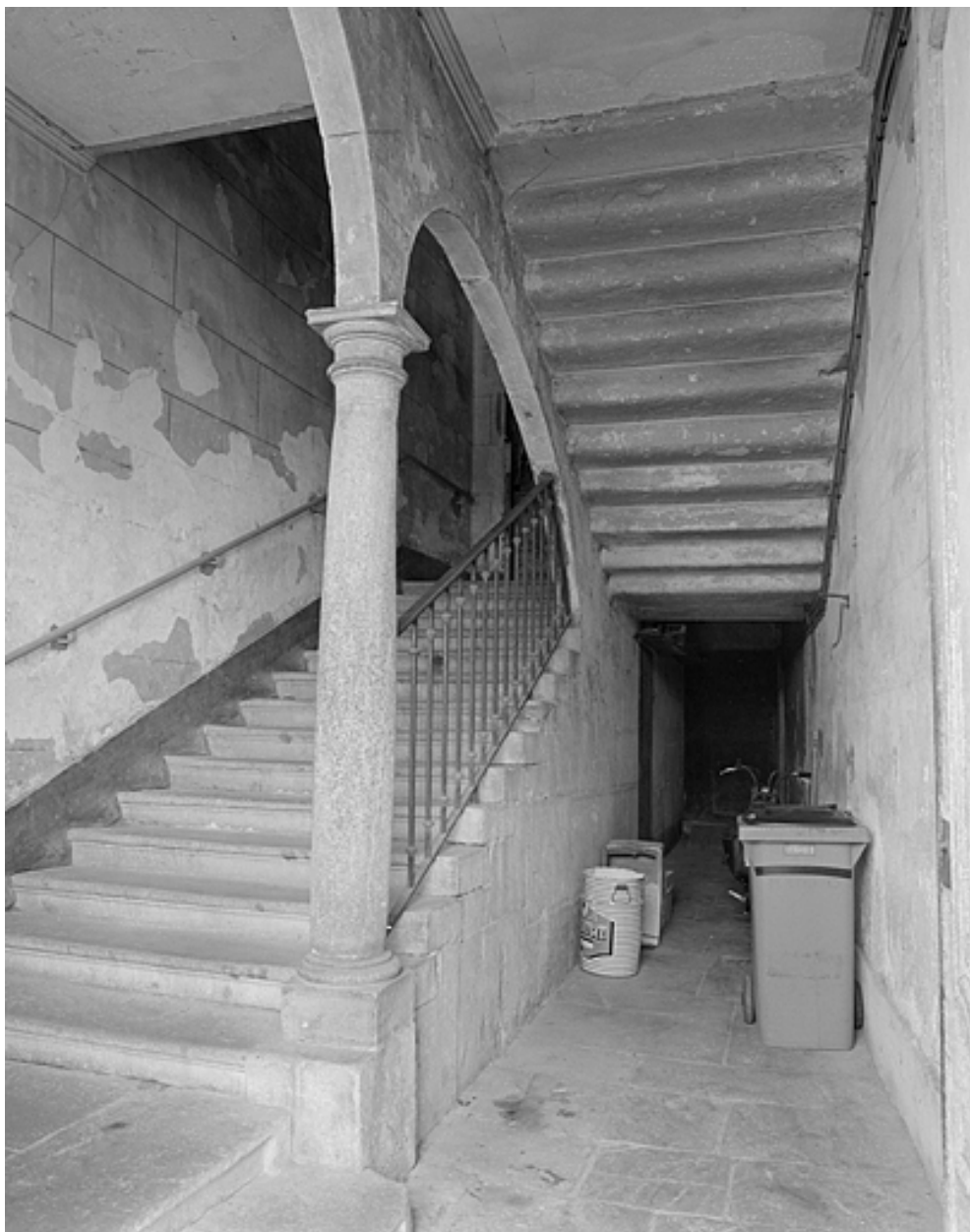
Vue de l'escalier depuis le vestibule.
