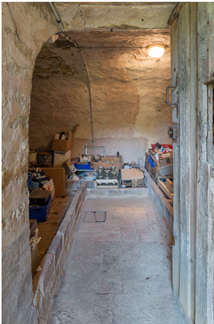
Le cellier servant de fruitier, vu depuis l'entrée.
