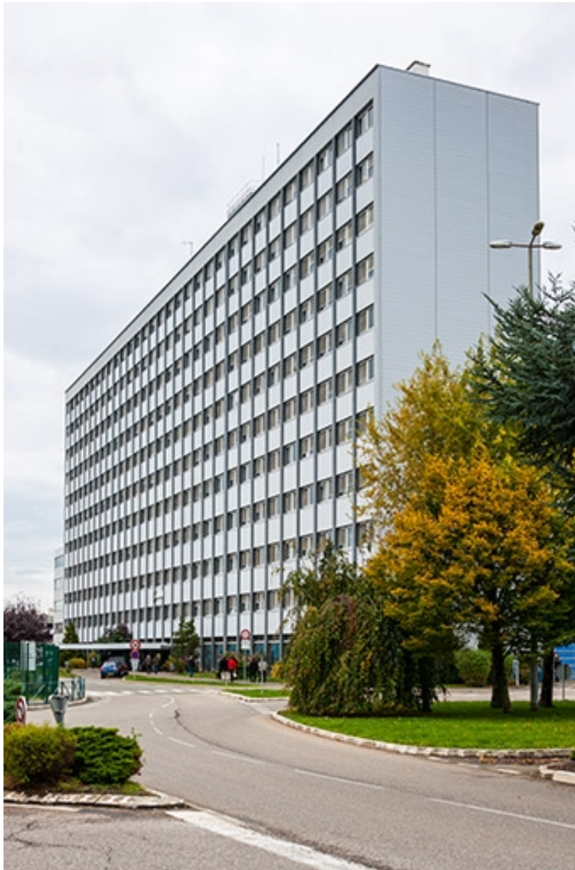
Centre de recherche (Building Ouest) depuis l'entrée.
