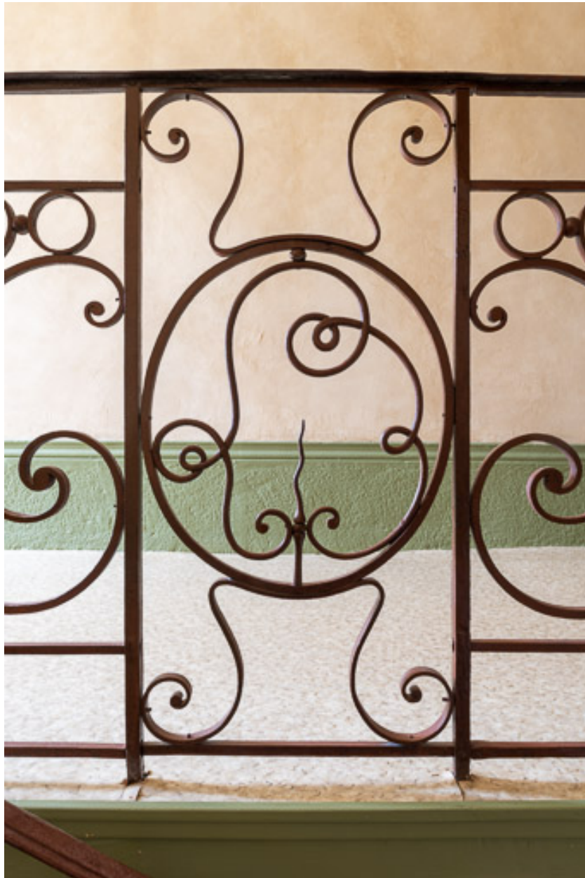
Garde corps en fer forgé de l'escalier avec le chiffre "LB" (Lazare Bordat)
