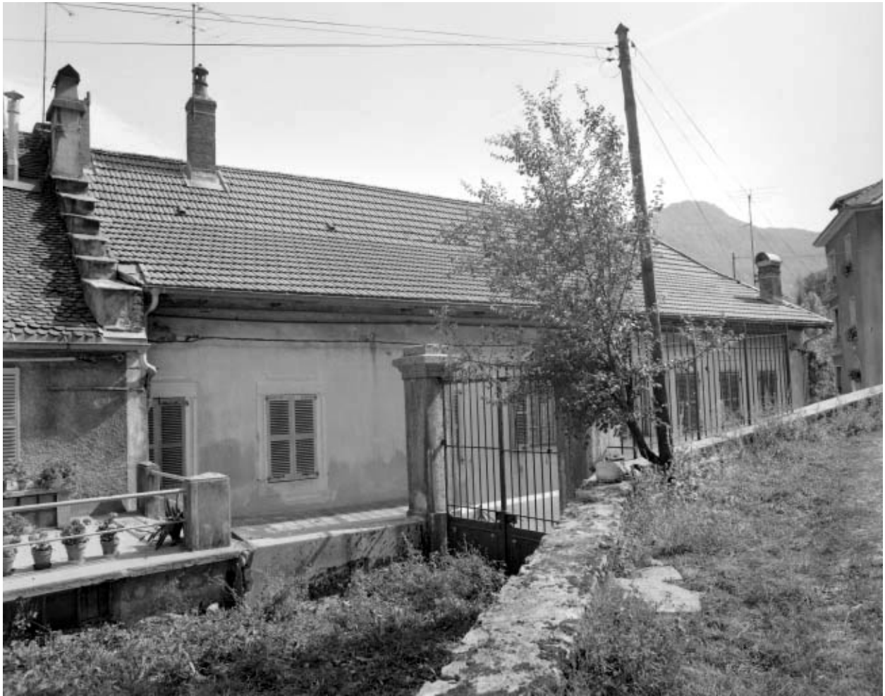
Logement patronal Dalloz : façade postérieure.
