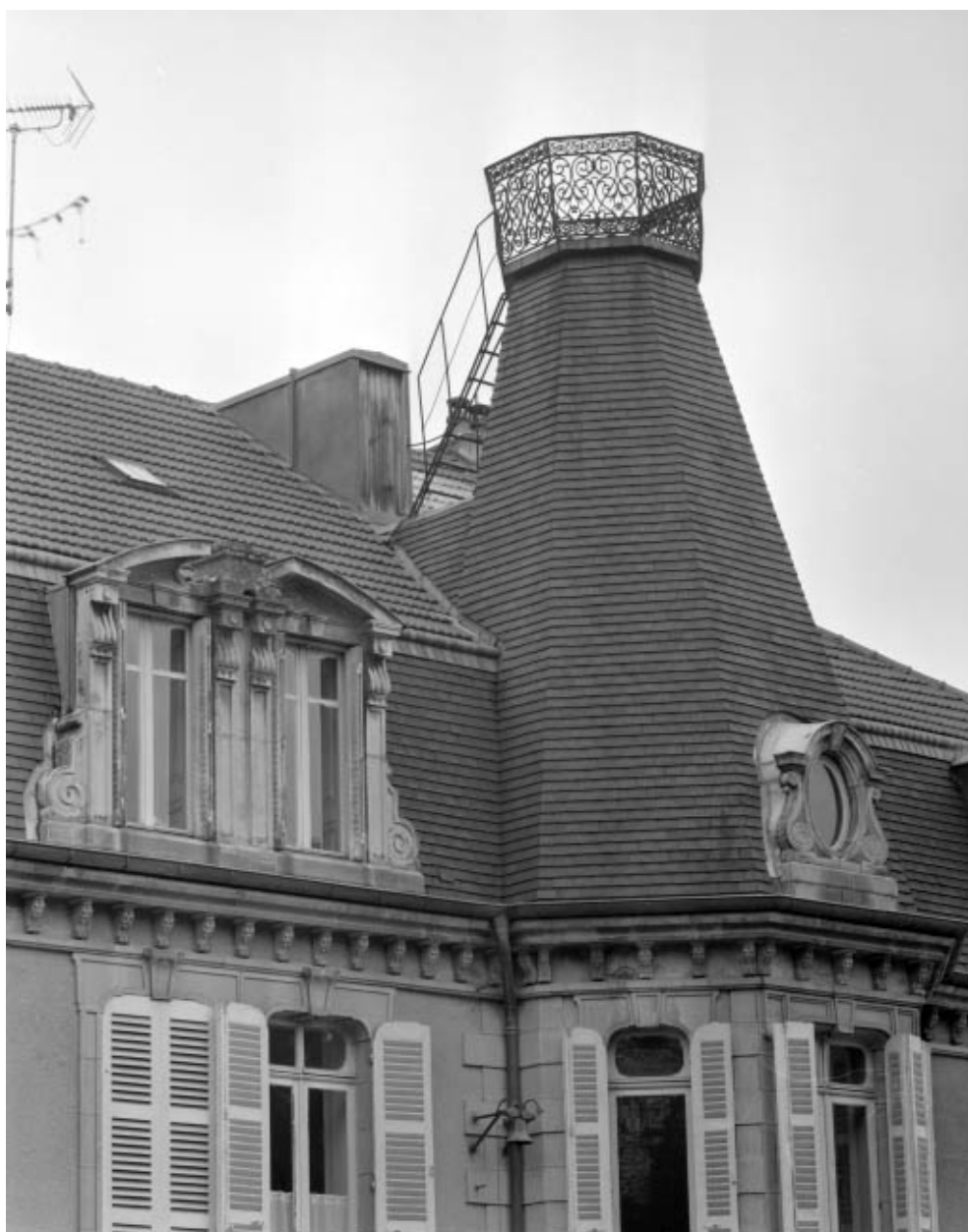
Château Béthanie : toiture de la tourelle d'escalier.
