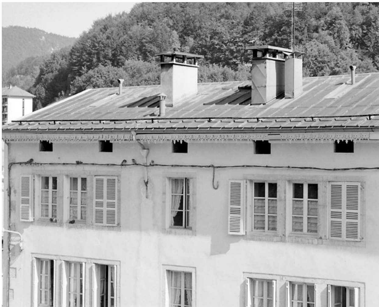
Façade antérieure : fenêtres jumelées aux étages.
