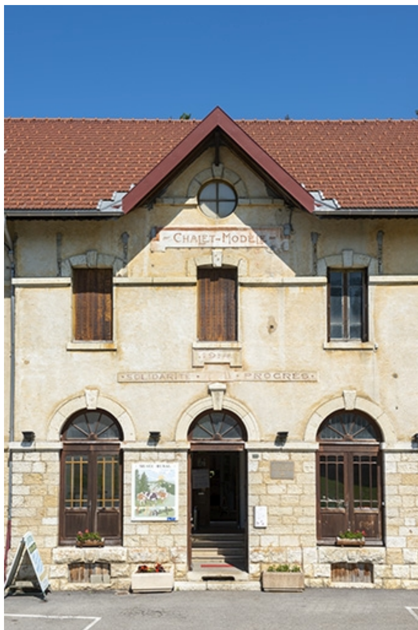
Partie centrale de la façade antérieure.
