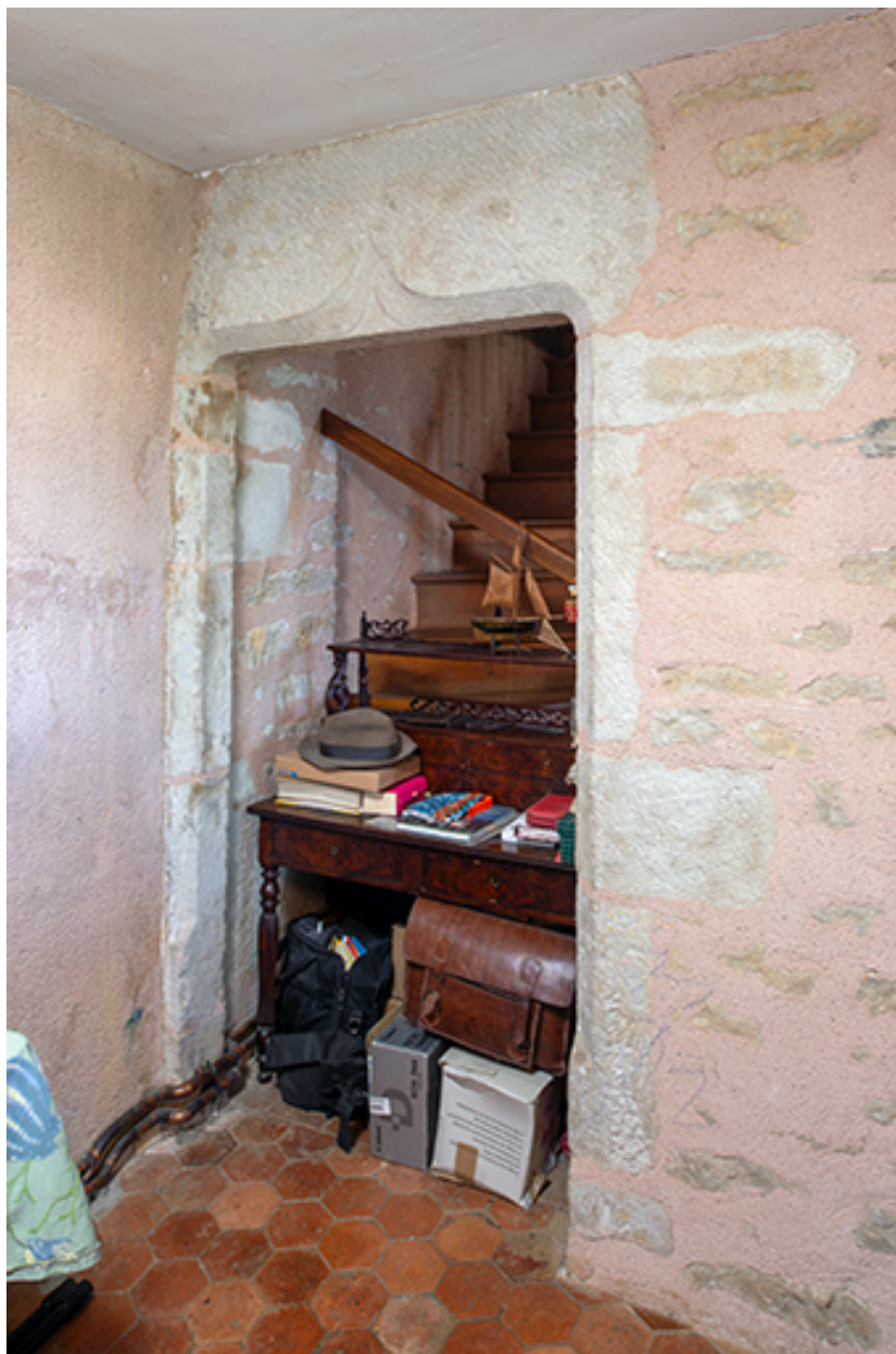
La porte située entre les deux pièces du rez-de-chaussée.
