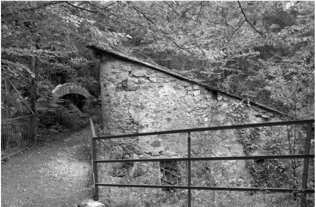
Site de la cascade : bâtiment d'eau.
