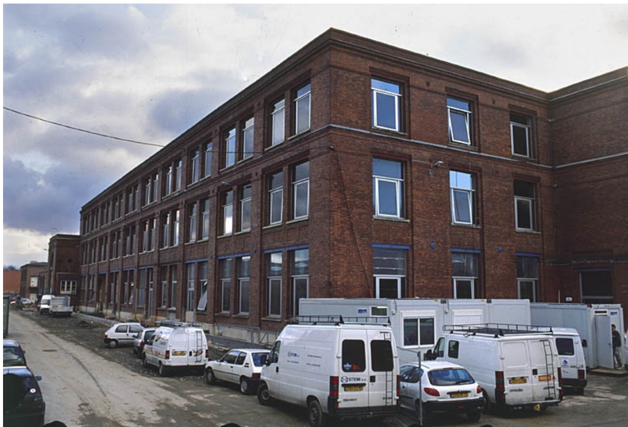
Atelier de filature : façade est.
