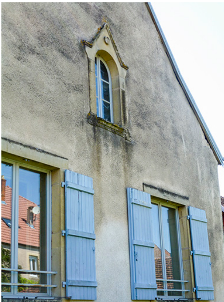
Façade postérieure : vue rapprochée.
