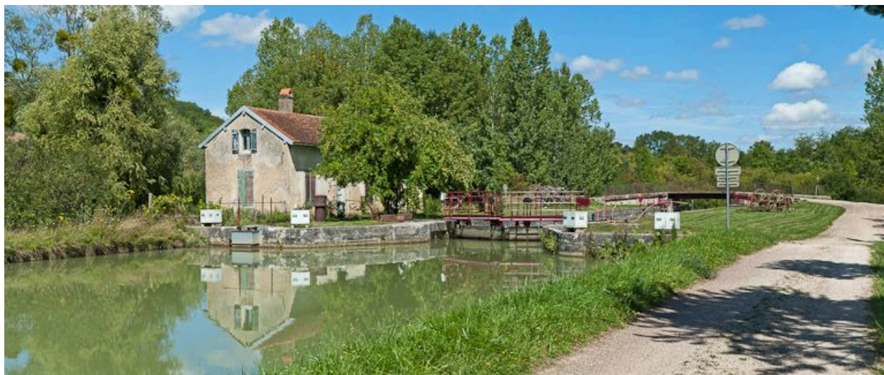
Vue d'ensemble du site d'écluse.
