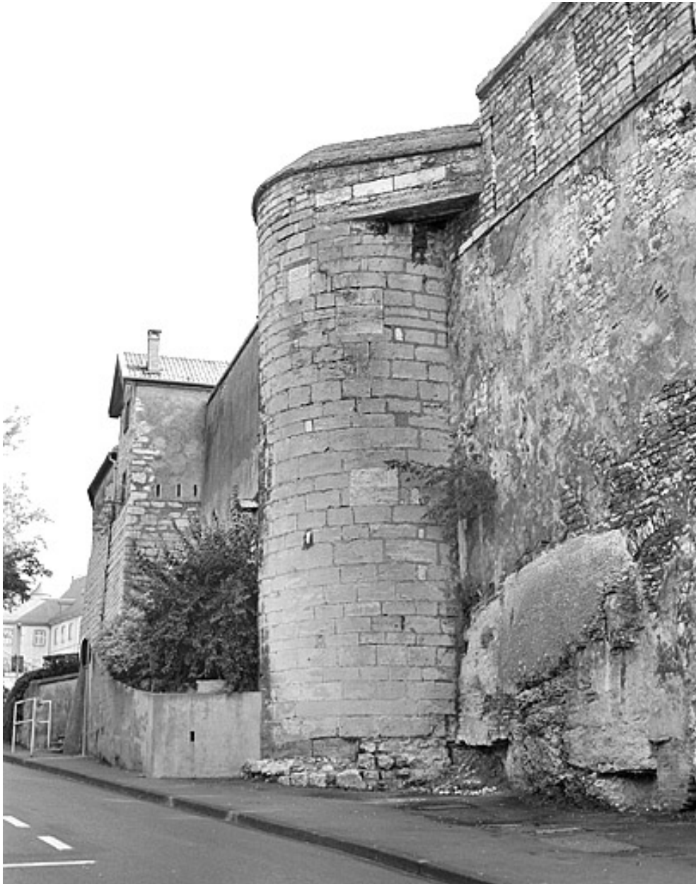
Enceinte. Tour de la porte (c).
