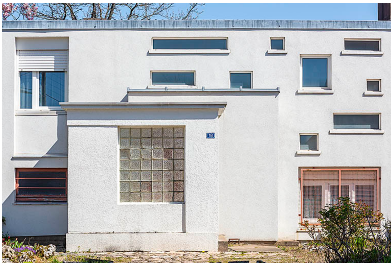
Presbytère. Détail de la façade sud-ouest.
