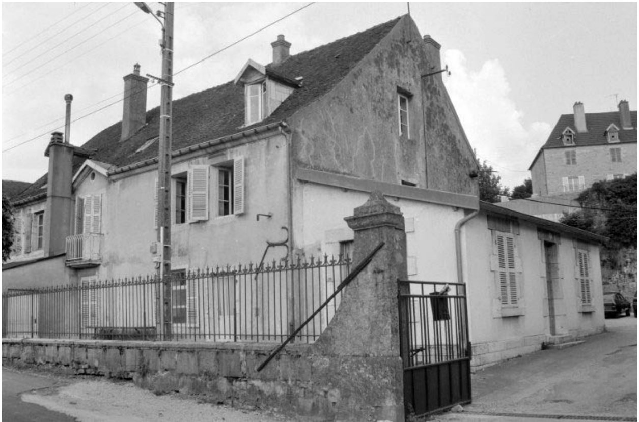
Bureau-logement patronal, vu de trois quarts droit.
