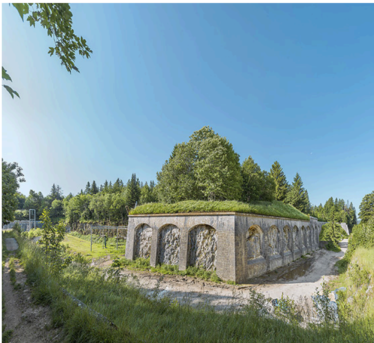
Bastion au front nord.
