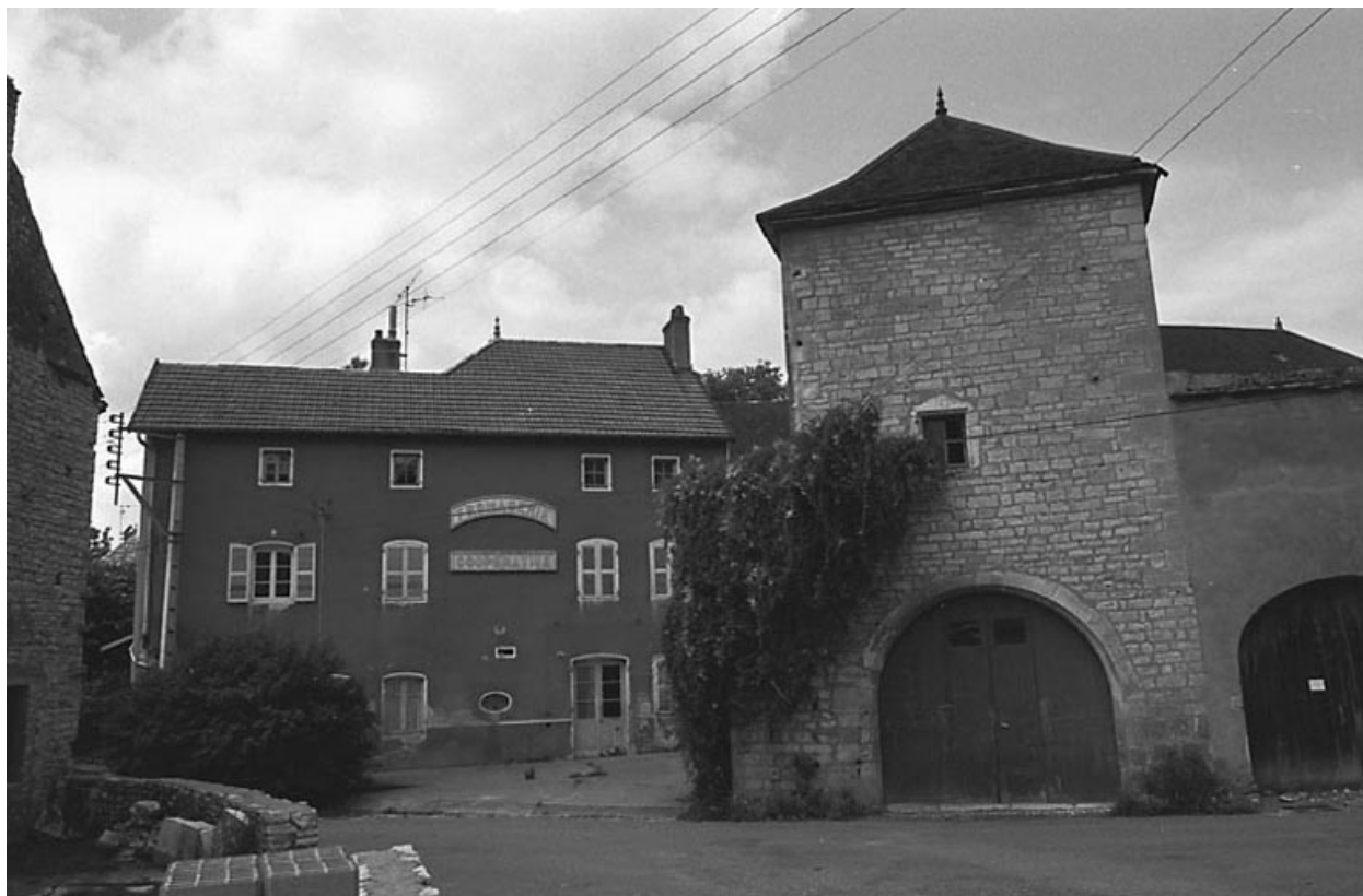
Montagney, maison située rue de la Fontaine.
