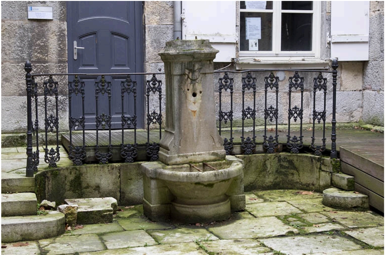
Vue d'ensemble de la borne-fontaine au fond de la cour.
