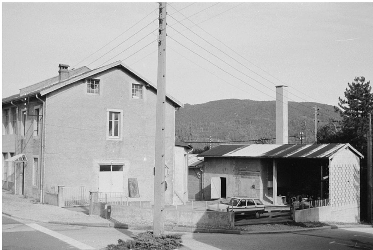
Façade latérale droite et chaufferie.
