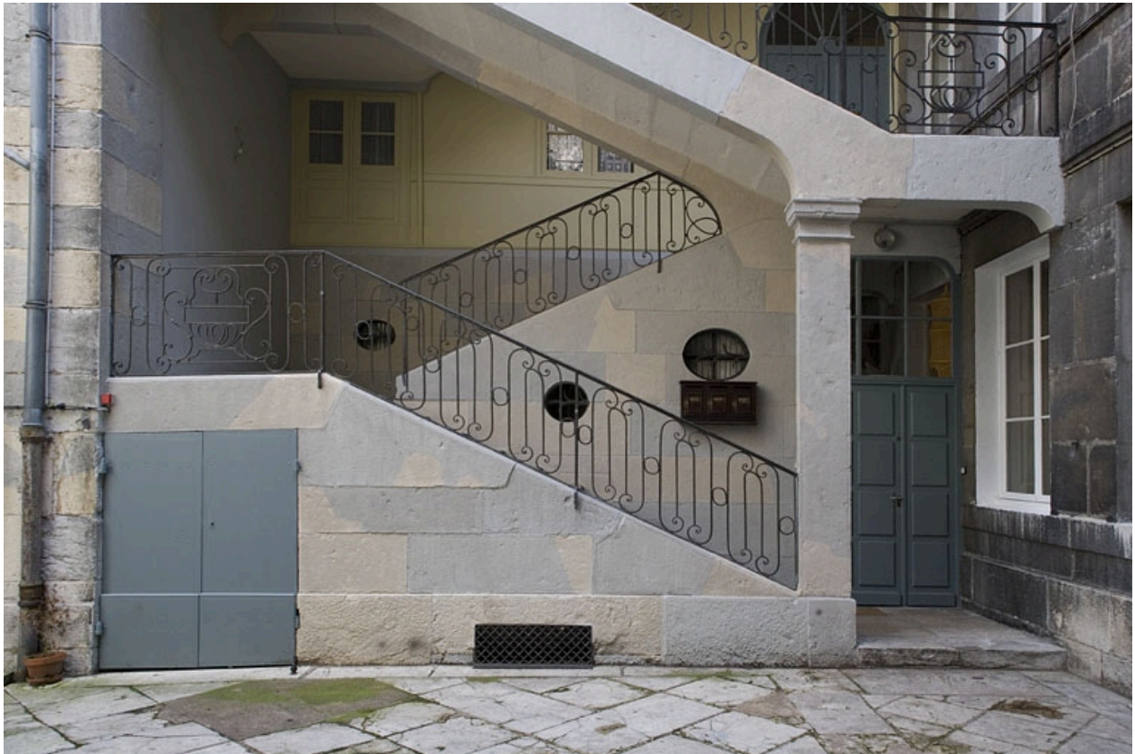
Détail des premières volées de l'escalier à cage ouverte.
