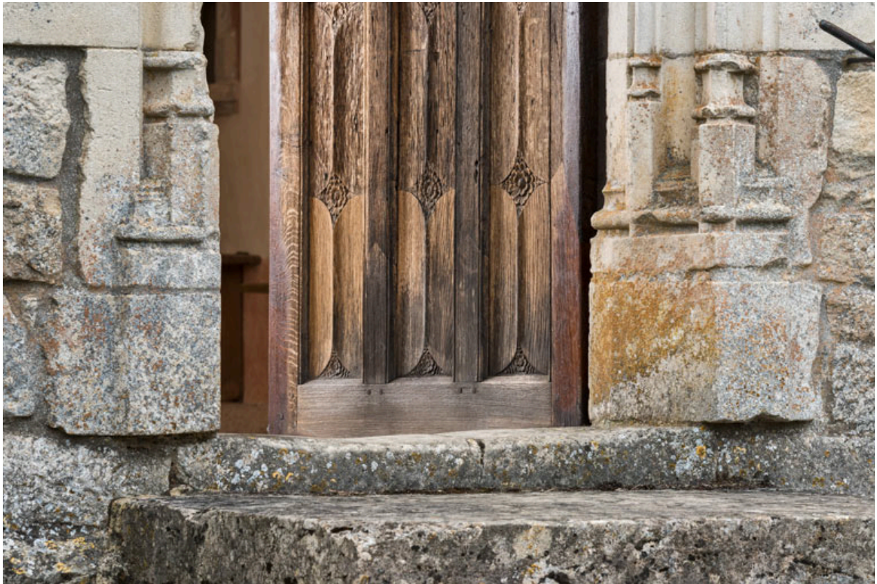
Piédroit, détail de la partie inférieure.
