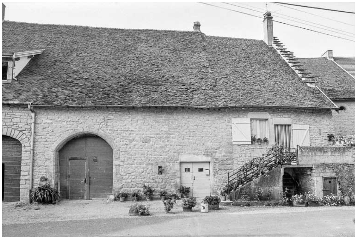
Ferme cadastrée AD 323 : façade antérieure.
