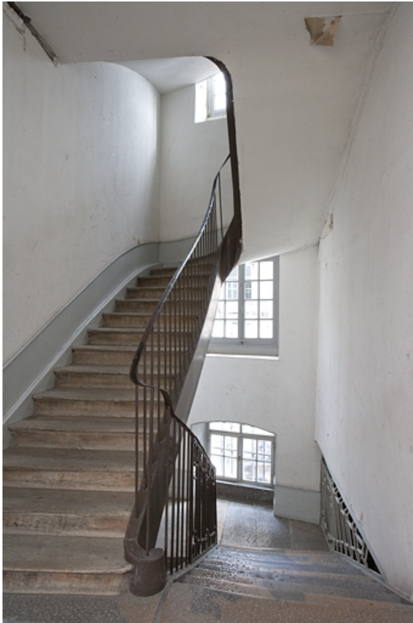
Détail de l'escalier : partie supérieure.
