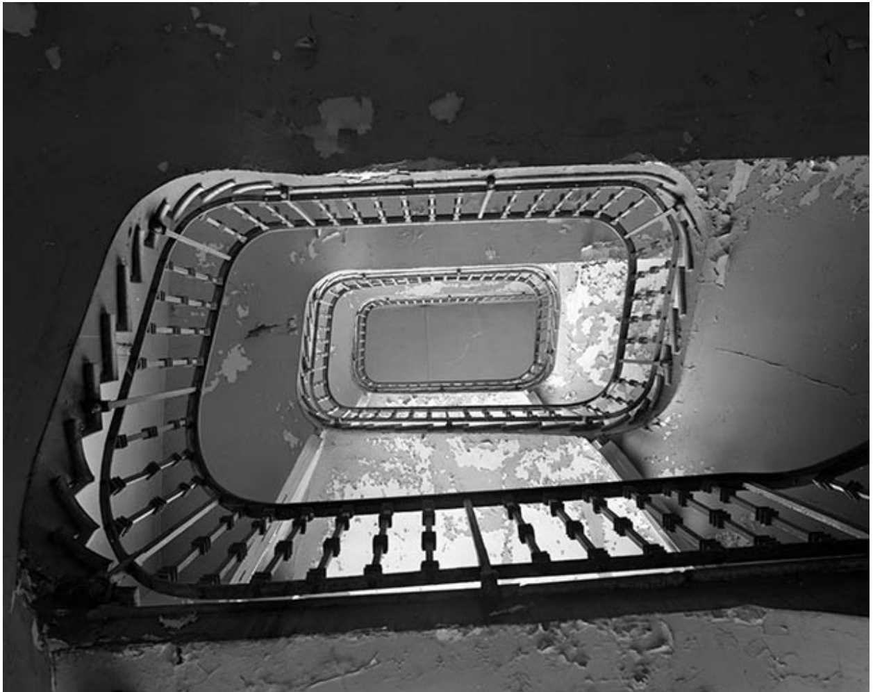
Escalier de la cantine.
