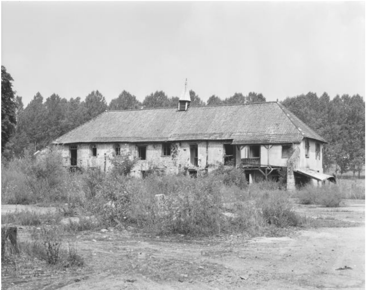
Le presbytère : façade ouest en 1980.
