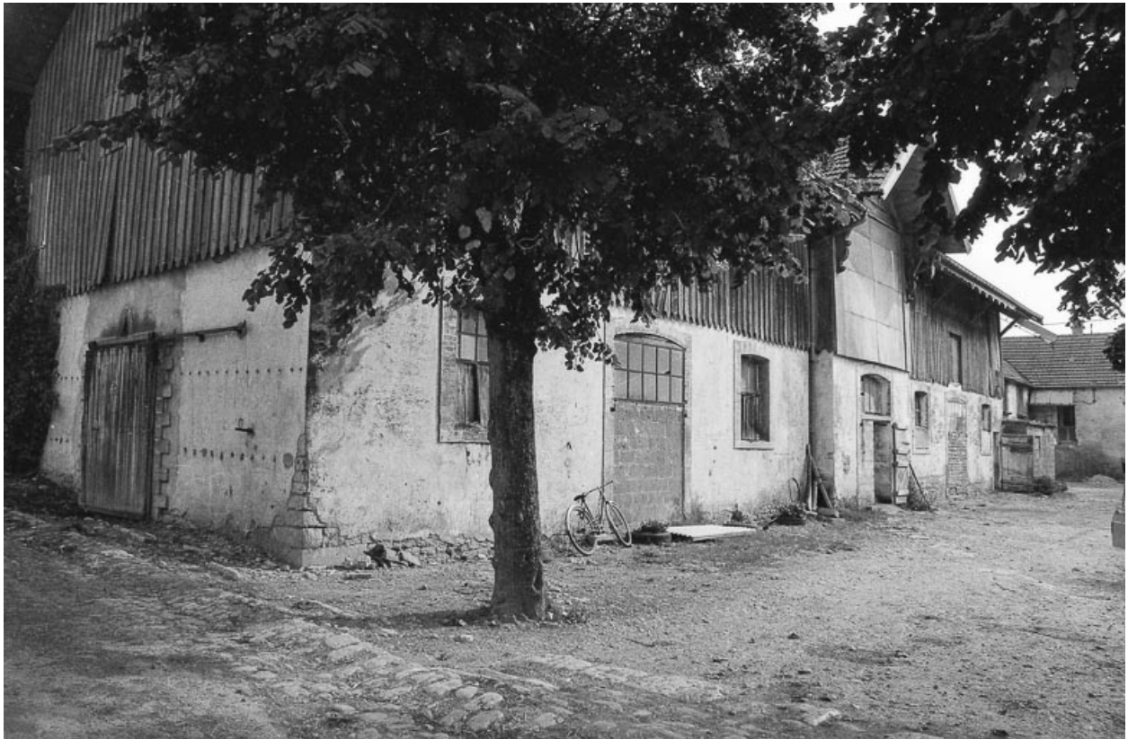
Maison située rue de l'Eglise.
