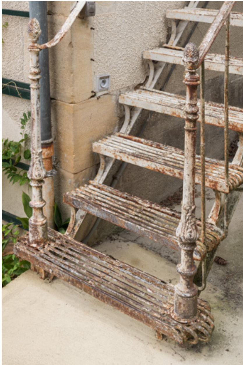
Escalier extérieur conduisant à l'étage, détail.
