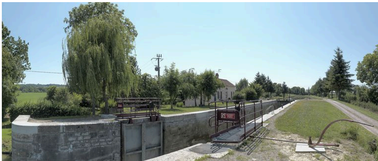
Le site d'écluse vu d'aval.
