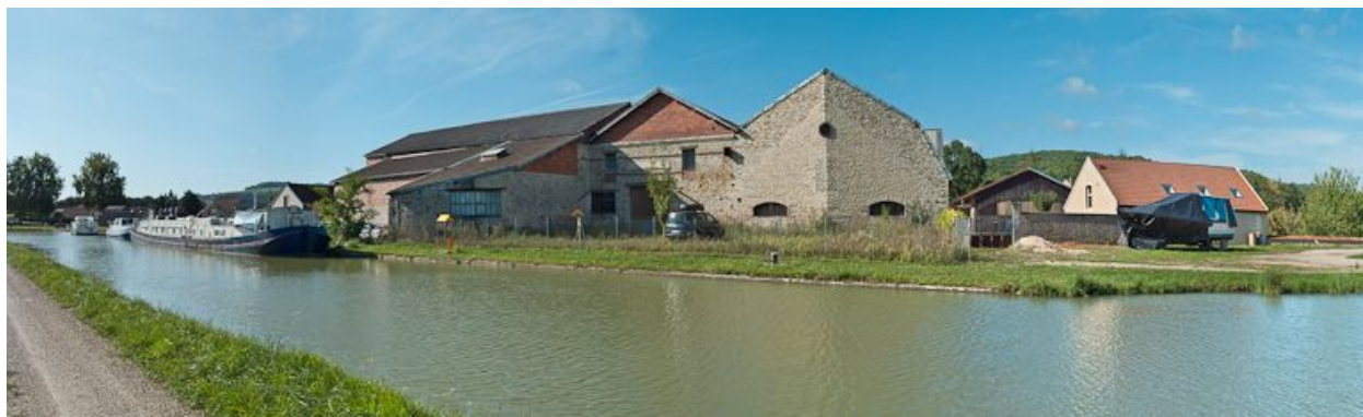
Vue de l'ancienne usine à chaux.
