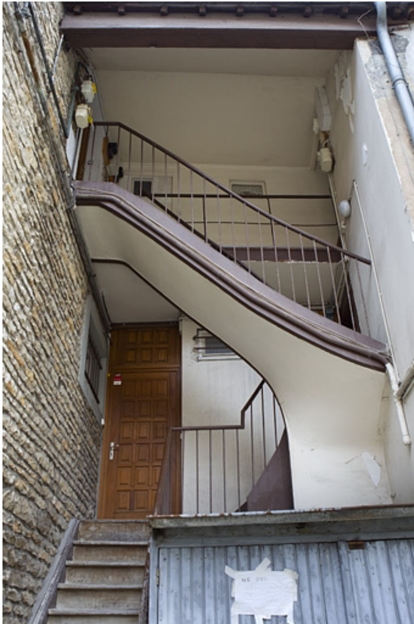
Vue d'ensemble de l'escalier à cage ouverte secondaire.
