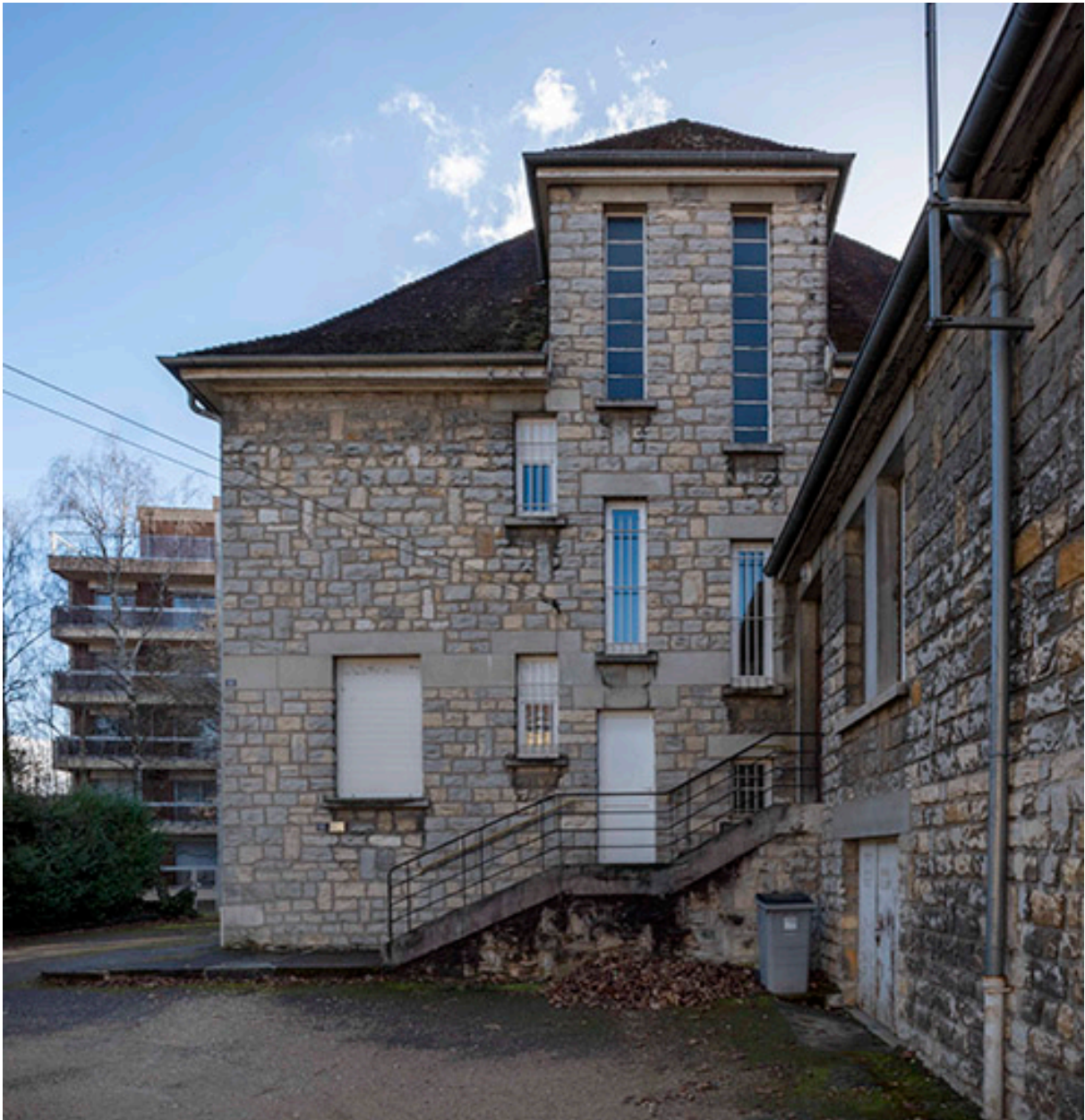
Façade nord du presbytère et bâtiment abritant la chapelle, la sacristie et la chaufferie de l'église.
