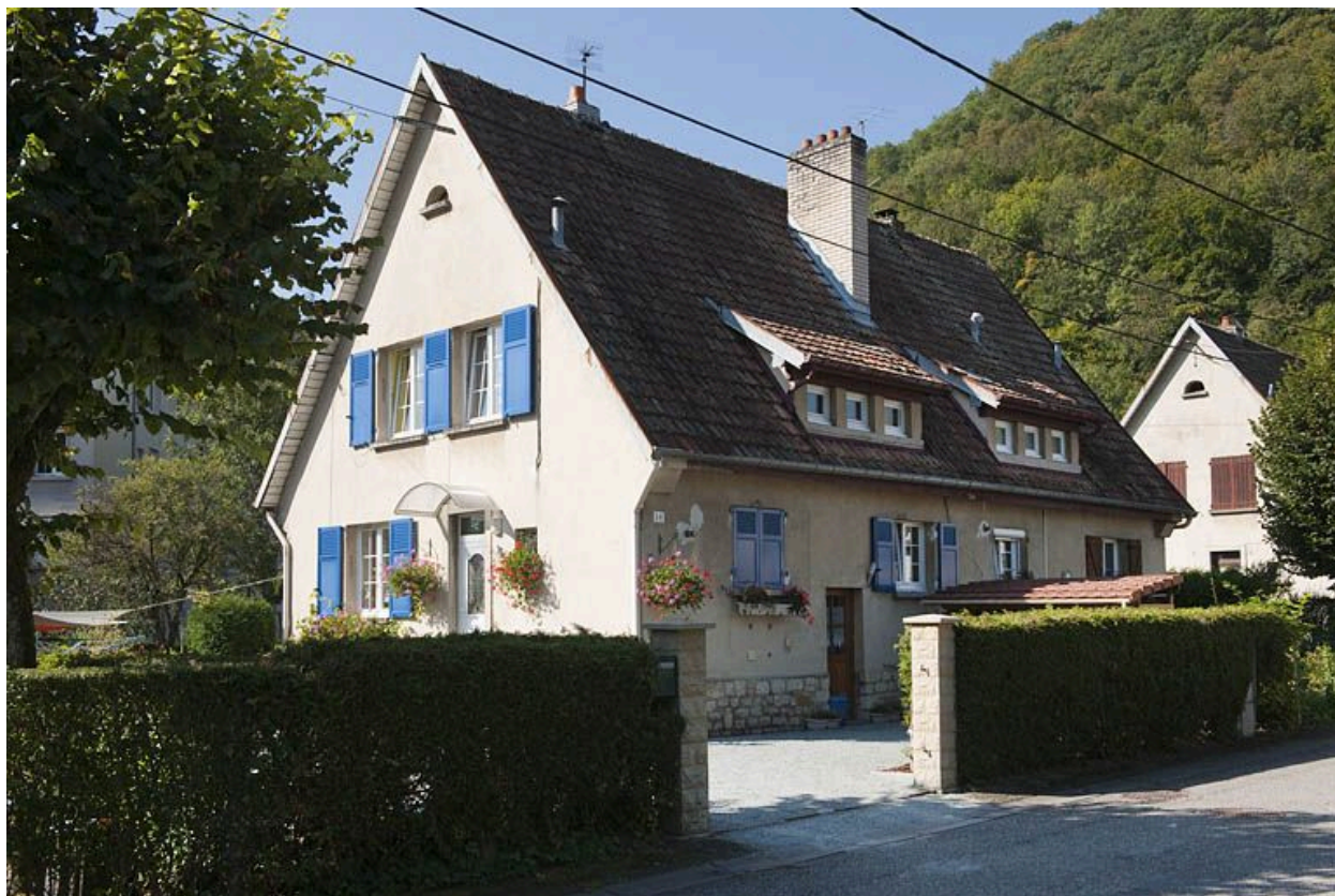
Maison jumelée. Pignon et façade nord.
