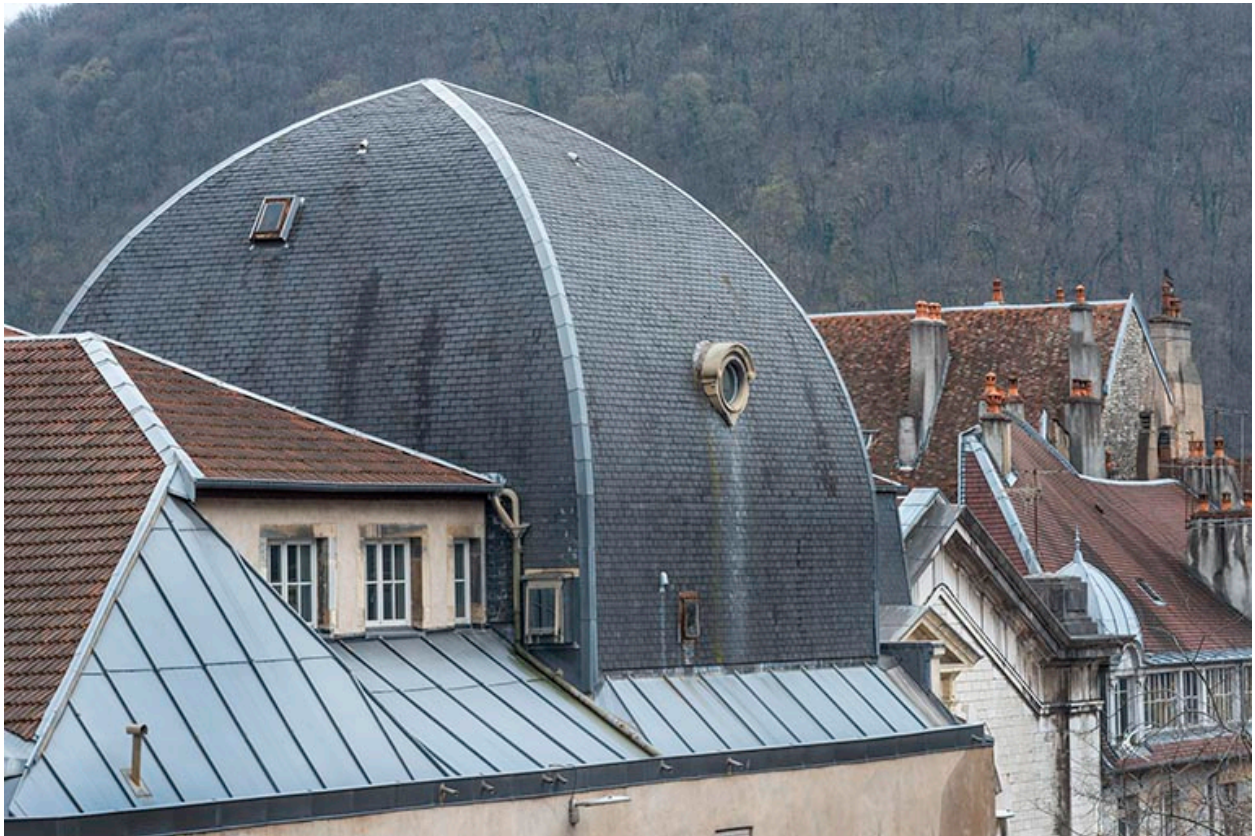
Bâtiment d'entrée, façade latérale gauche : toitures vues du nord.
