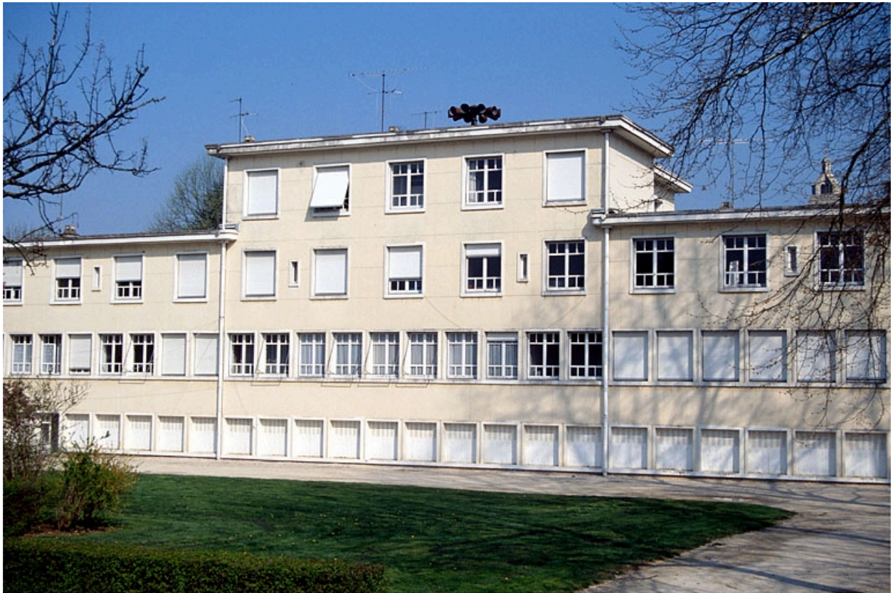
Façade postérieure, partie centrale.
