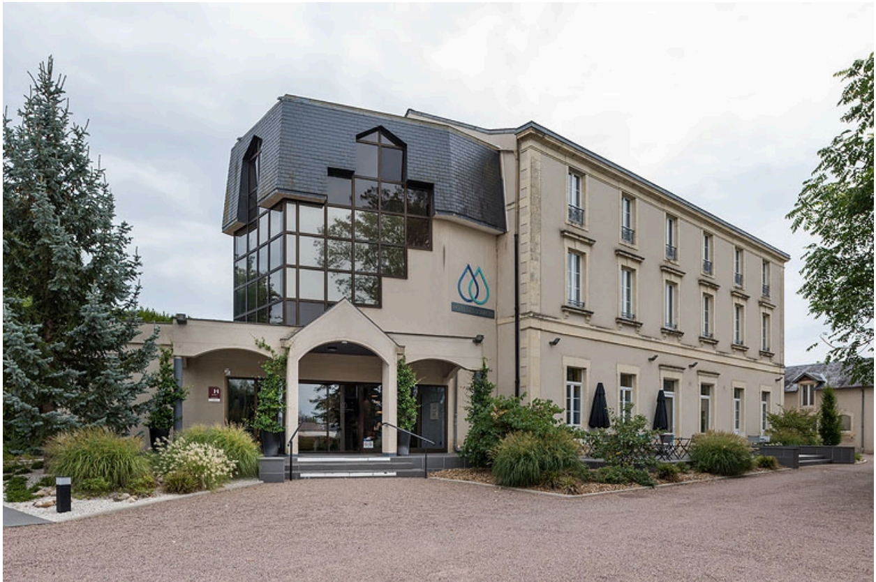
Façade après les travaux de modernisation de 2017.
