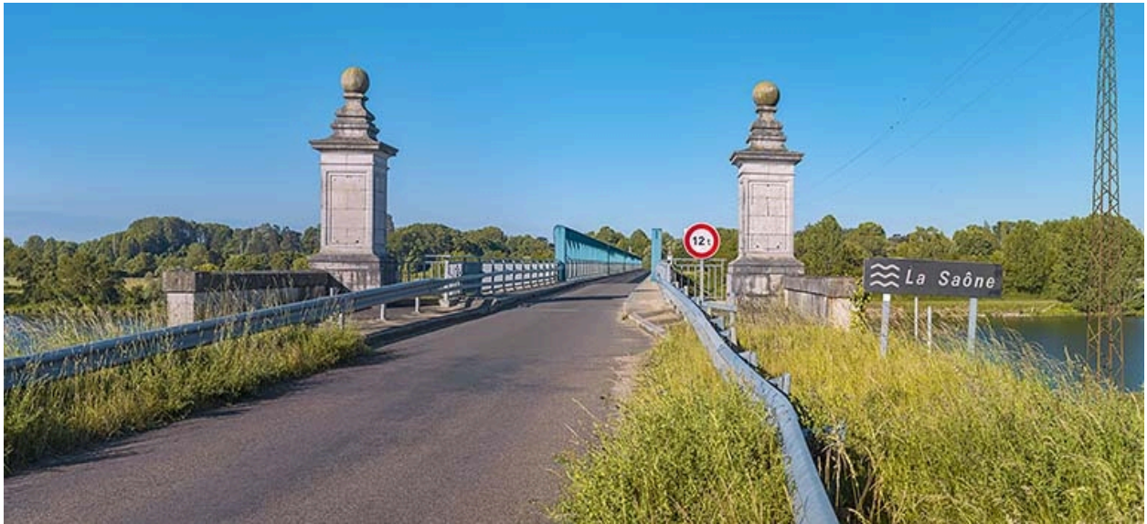
Entrée du pont.
