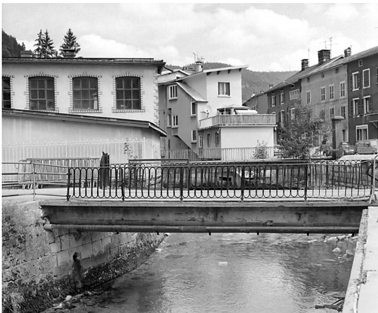
Le pont du Casino en 2000.
