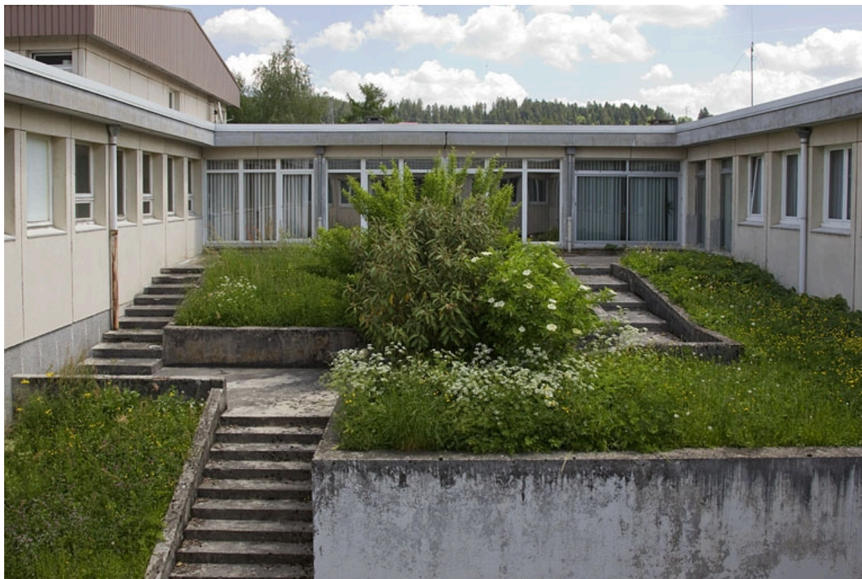
Bâtiment de l'administration : patio.
