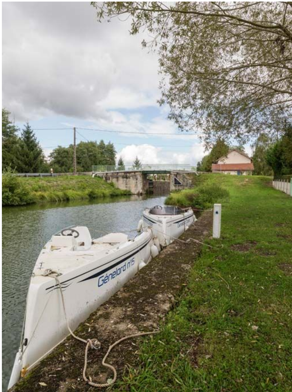
Vue d'ensemble du pont.
